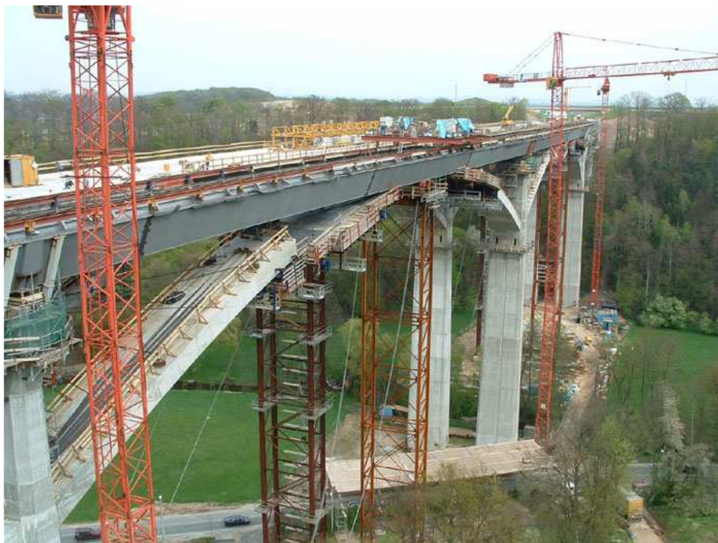
Obr. 2 – Stavba mostu Lockwitztalbrücke (druhý úsek)
