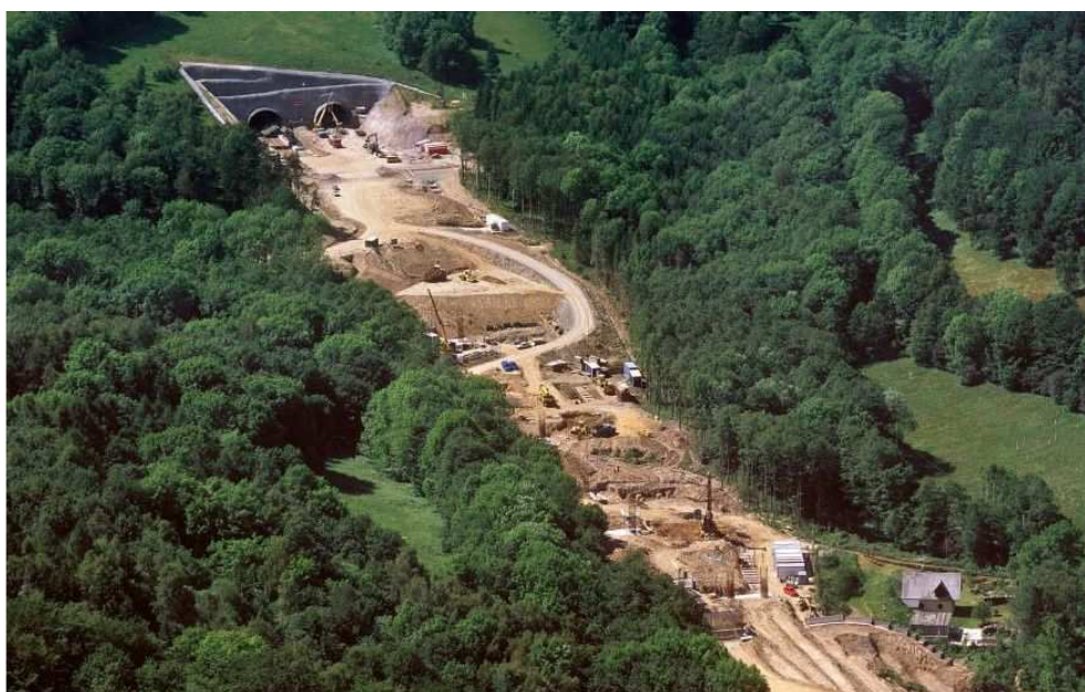
Obr. 1 – Stavba jižního portálu tunelu Panenská
